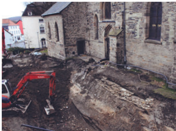
Die bei der Ausschachtung entdeckten Fundamente. Foto Bruno Giersch.
