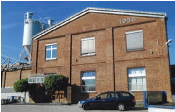
Das heutige Verwaltungsgebäude der Firma „Quick Bauprodukte“.
