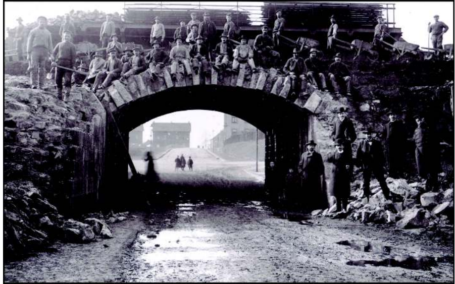
Foto vom Abbruch der ersten Bahnunterführung des Holzener Weges, 1904, aus dem Bestand des StASchwerte
