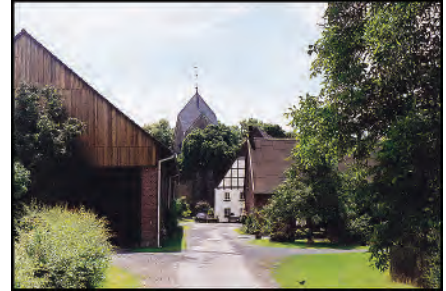
Der Schultenhof zu Bausenhagen, die ehemalige „curtis Busenhagen“, mit der früheren „Hofeskirche“ und jetzigen ev. Pfarrkirche. Nordansicht. Foto: R. Stirnberg, 2004.
