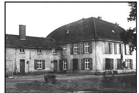
Das 1819 neuerbaute Wohnhaus des Dellwiger Schulzenhofes mit seinem charakteristischen Bohlenlamellendach und jüngerem Anbau, Hofseite. Foto: Sammlung Stirnberg
